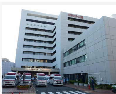
建て替えが予定されている広尾病院
